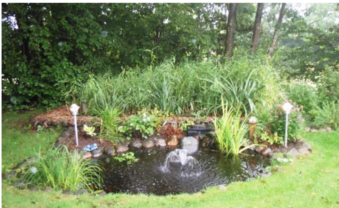
Beplantet filteranlæg på 16 m 2 til 1 husstand, fint integreret ved siden af en havedam, Silkeborg
