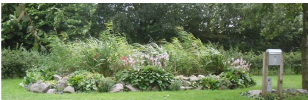
Beplantet filteranlæg på 16 m 2 til 1 husstand på maks 5 personer ved Lemvig
