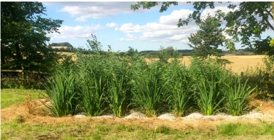
Spildevandsrensning til 10 husstande i Havdrup med beplantede filteranlæg på 25 m 2 med aktiv beluftning
